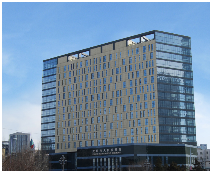
沈阳市检察院
