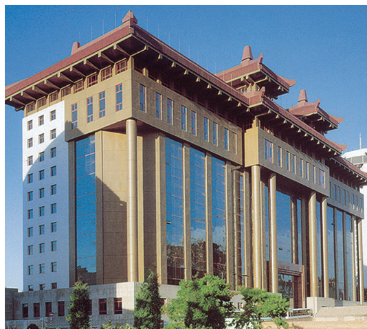
交通部办公楼
